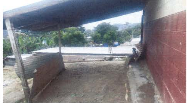
Fotos 2: Reparación de plancha de concreto.
