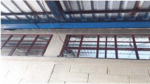
Foto 1: Sustitución de balcones de metal.
