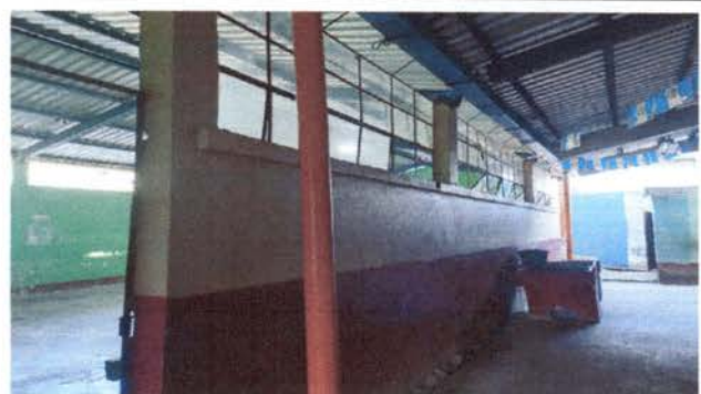
Foto 4: Sustitución de tuberías PVC línea principal de aguas fluviales y sustitución de canales de metal.
