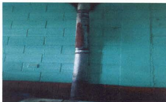
Foto 10: Sustitución de chimenea de metal cocina.
