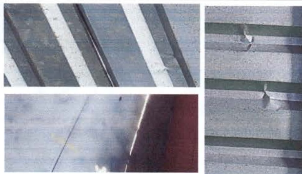
Foto 9: Sustitución de láminas troqueladas.
