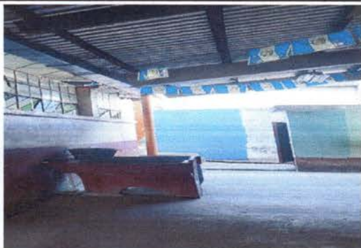
Foto 7 Sustitución de lámparas aulas y corredor.
