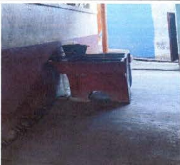
Foto 5: Sustitución de pila de cemento de 2 lavaderos.
