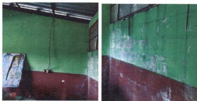
Foto 11: Pinturas en muros interiores y exteriores.
