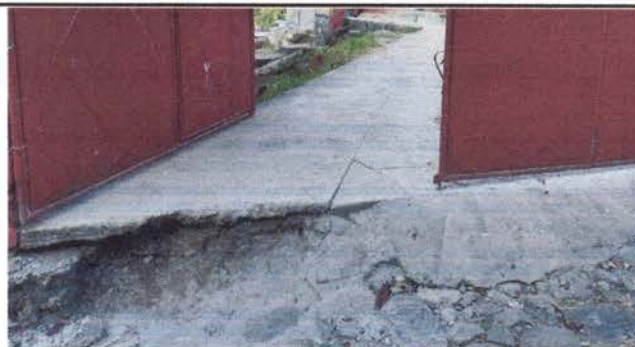
Foto 8: Reparación de banqueta de concreto.
