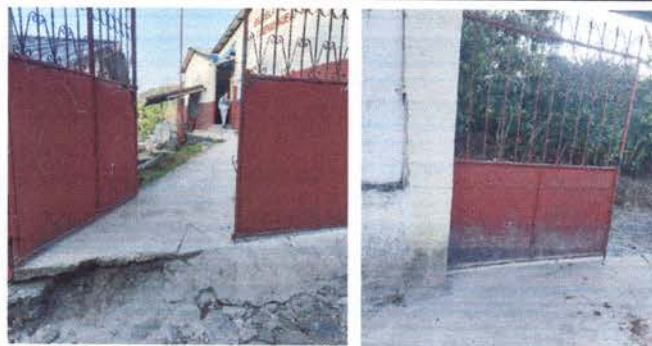
Foto 12: Mantenimiento a estructuras, portón, puertas
